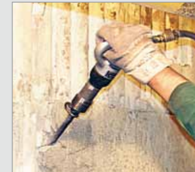
Semplice rimozione di intonaco e piastrelle
