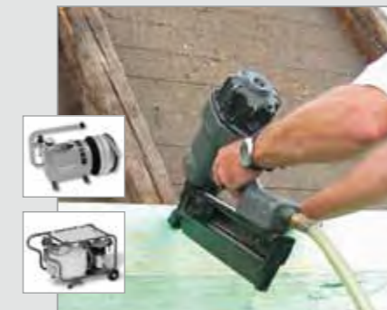
Chiodatura veloce e precisa dei listelli del tetto e della pannellatura
